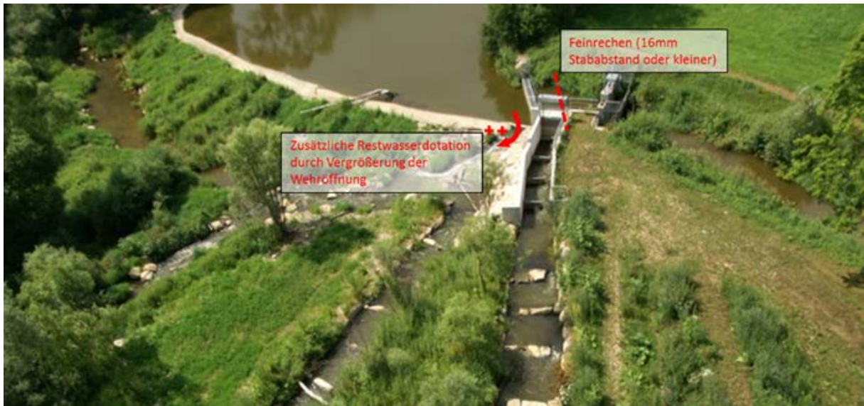
Abbildung 78: Konzept der Adaptierung des Standortes Riedmühle zur Optimierung der Durchwanderbarkeit und des Fischschutzes.
