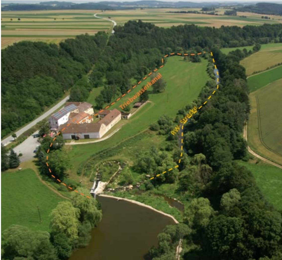
Abbildung 10: KW Riedmühle in Blickrichtung flussab. Auf der linken Seite der Triebwasserkanal, in Bildmitte die FAH, Wehr und Wehrdotations sowie die Restwasserstrecke. Zusammenfluss von Triebwasser und Restwasser im Staubereich des unterliegenden Kraftwerkes.
