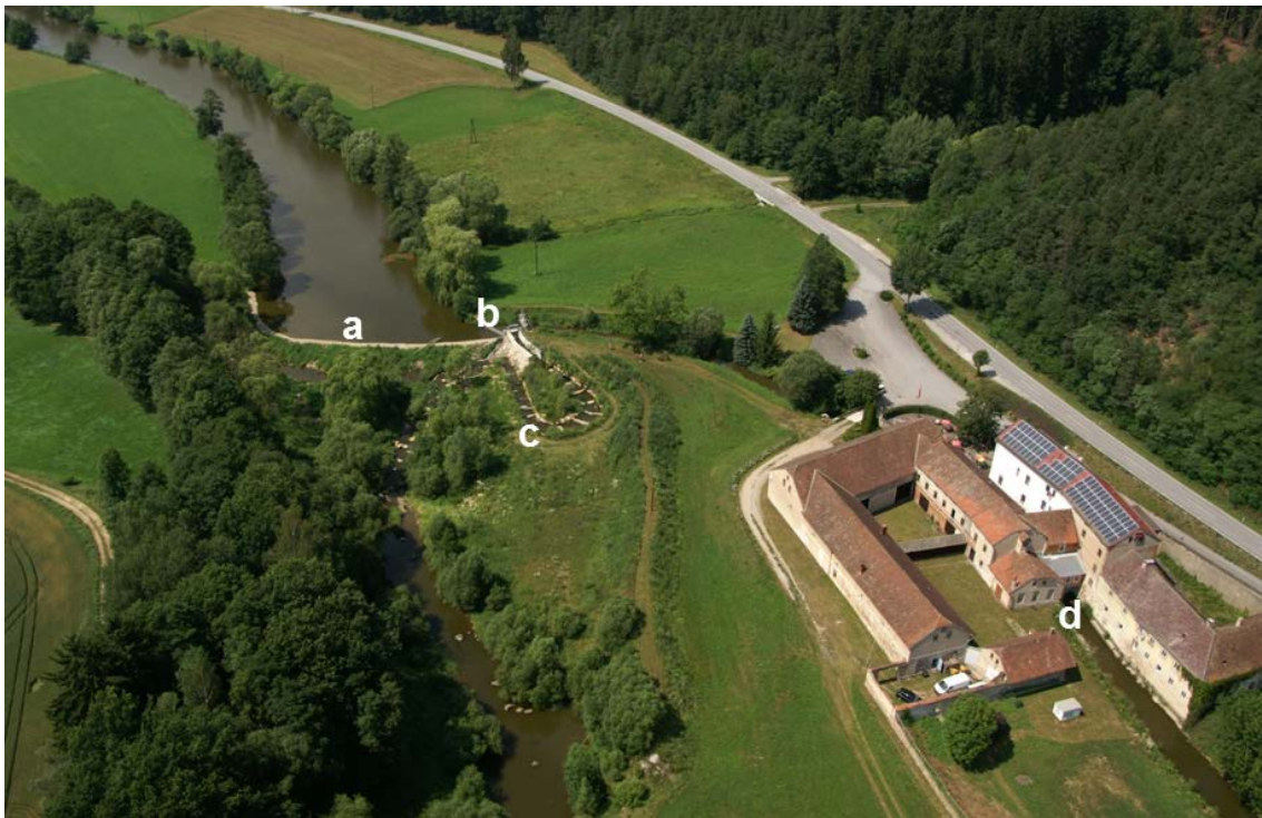
Abbildung 7: Kraftwerksstandort Riedmühle: a) Wehranlage ca 45 m; b) Abzweigung Triebwasserkanal, Tauchwand, Wehrdotation und Fischaufstiegshilfe; c) Fischaufstiegshilfe und Anbindung ins Unterwasser (Restwasserstrecke); d) Krafthaus mit Feinrechen, im OW Tauchwand und Fischabstiegsanlage.
