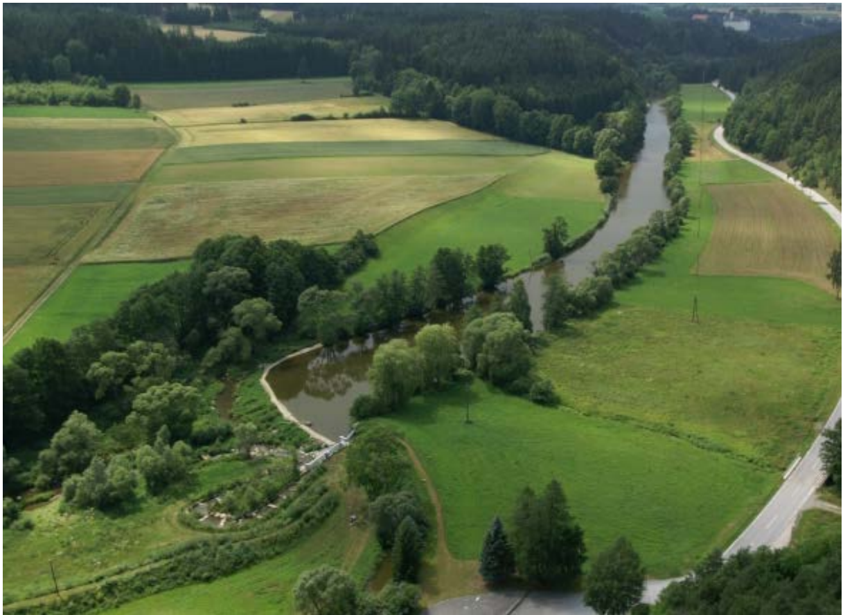
Abbildung 28: Staubereich des KW Riedmühle mit der Wehranlage im Vordergrund.
