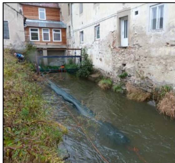
Abbildung 56: Monitoringdaten zur Untersuchung der Abwärtswanderung über die FAbH (links) und Abbildung des exponierten Fangnetzes am Auslassrohr der Abstiegshilfe (rechts).
